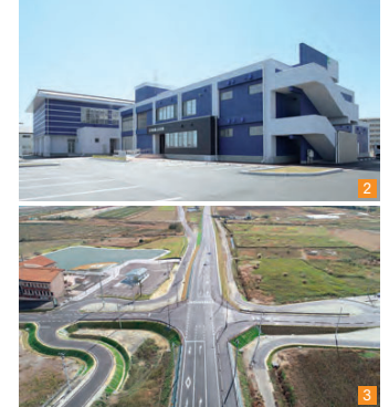
2 「名取市関上公民館・体育館」改築工事も担当した（名取市）。 3 坂元道路改良工事（山元町）。
