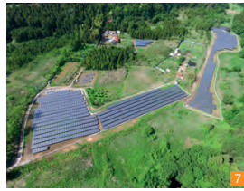
7 再生可能エネルギー事業「太陽光発電所」（千葉県八街市）。
