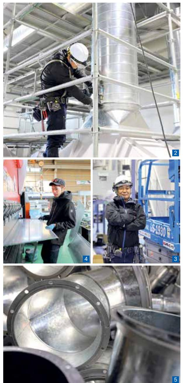
■農・工業プラント設備の施工実績は随一。全国あらゆる現場のオーダーに応えている。②きめ細やかな安全対策と技術力の高いスタッフによる施工で、クリアントからの信頼も厚い。③繁忙期は社長自ら現場に出向くことも。「社員と共に汗を流すのがモットーです」と矢口社長。④先輩が若手社員に技術を伝承する社内環境が整う。最新鋭の機器導入はもちろん、職人一人ひとりの技術力が品質の高い製品を生み出している。⑤ダクトやスピアラルダクト、煙道など、ニーズに合わせたさまざまなダクトを製作する。
