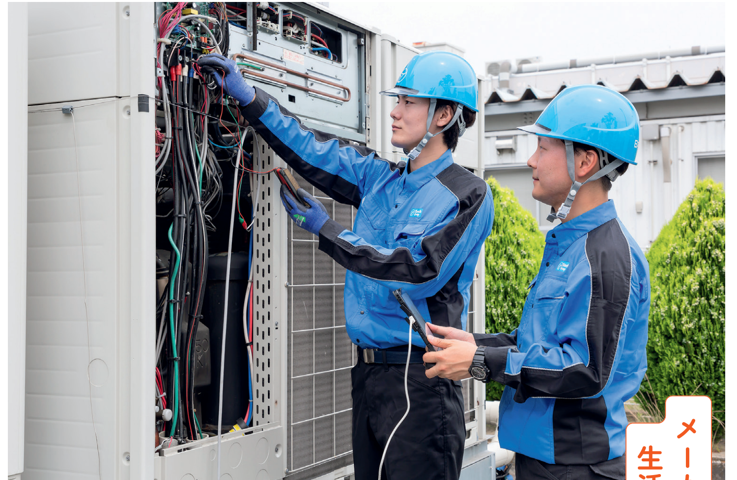
空調設備の点検作業。電流値、電圧値などのデータを取り機器を保全。安全で安心できる空間を守る。
