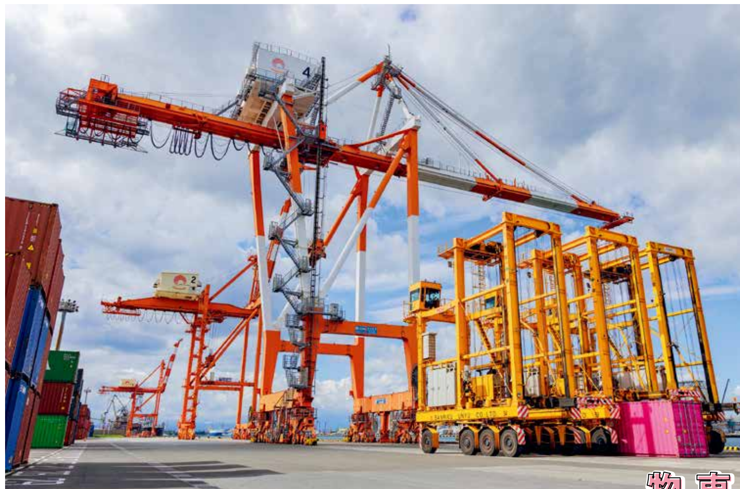
仙台塩釜港のコンテナターミナル。奥がガントリークレーン(赤白)、手前がストラドルキャリア(黄色)。
