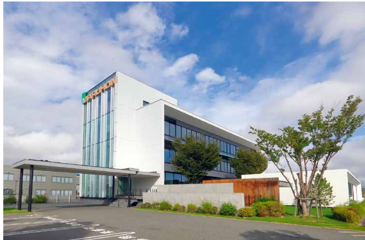
震災の経験を活かし、防災対策が万全に施された本新社屋(石巻市)。
